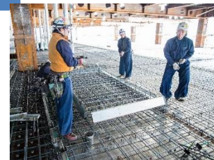
【鋼製型枠を鉄筋上に取付けている作業風景（左が外国人材）】
