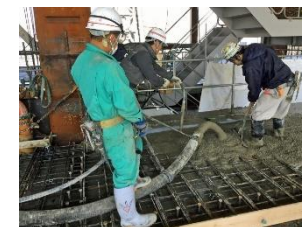
【圧送ポンプを利用して型枠内にコンクリートを打ち込むところ】
