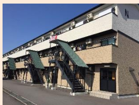
新設した外国人専用の寮 (外観)
