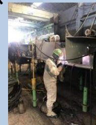
溶接作業の様子
